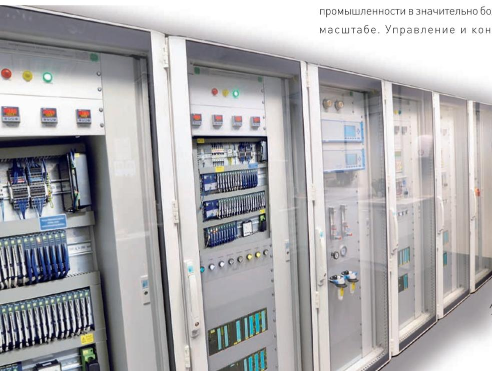
*Автоматизированная система управления JUMO mTRON T и встроенные приборы в распределительном шкафу*
